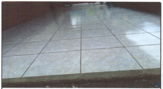
Foto 4: Sustitución de piso de torta de concreto por piso ceramico, en corredor.
