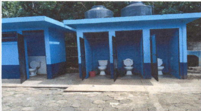
Foto 3: Sustitución de sanitarios y sus accesorios en modulo de baños 1 y 2.
