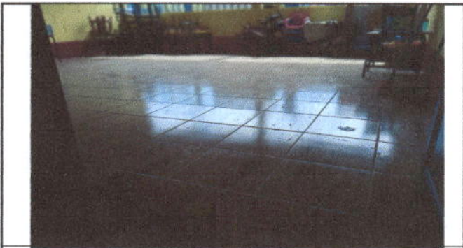
Foto 5: Sustitucion de piso de torta de concreto por piso cerámico en modulo 4.
