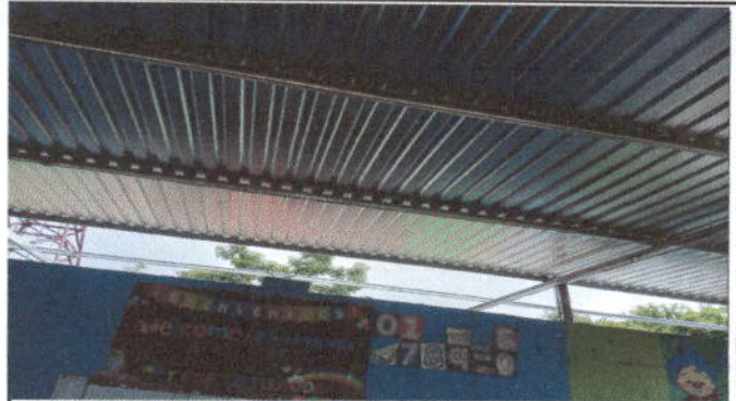
Foto 2. Sustitucion de estructura de soporte de madera por metal. Modulo 3
