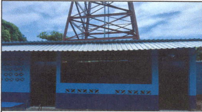
Foto 1: Sustitución de lámina por lamina troquelada aluzinc calibre 26, En el area de Cocina.
